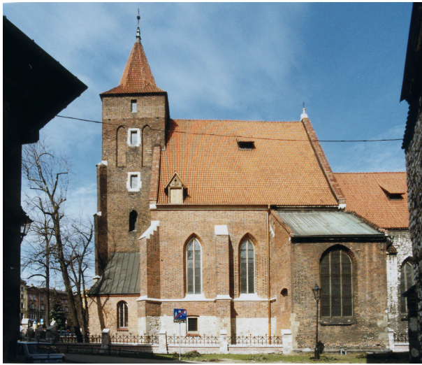
Heiligkreuzkirche in Krakau - einfaches, geschlossenes Ziegel- und Steingebäude aus dem 14. Jahrhundert.
